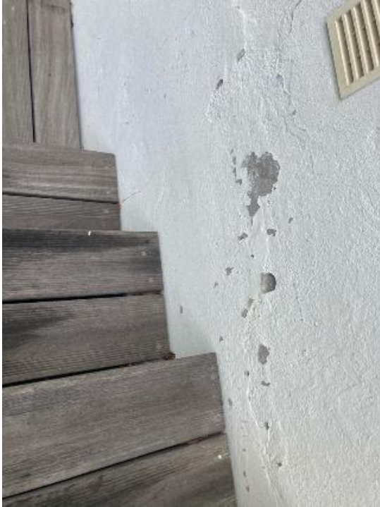
Soubassement face nord
