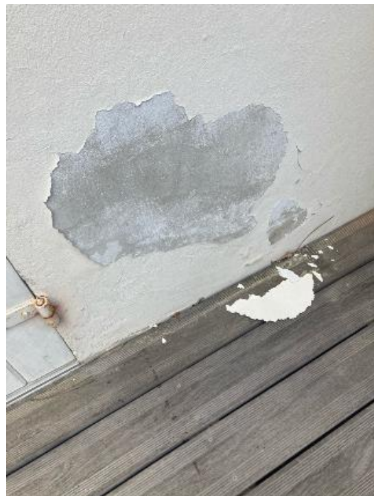
Soubassement face nord
